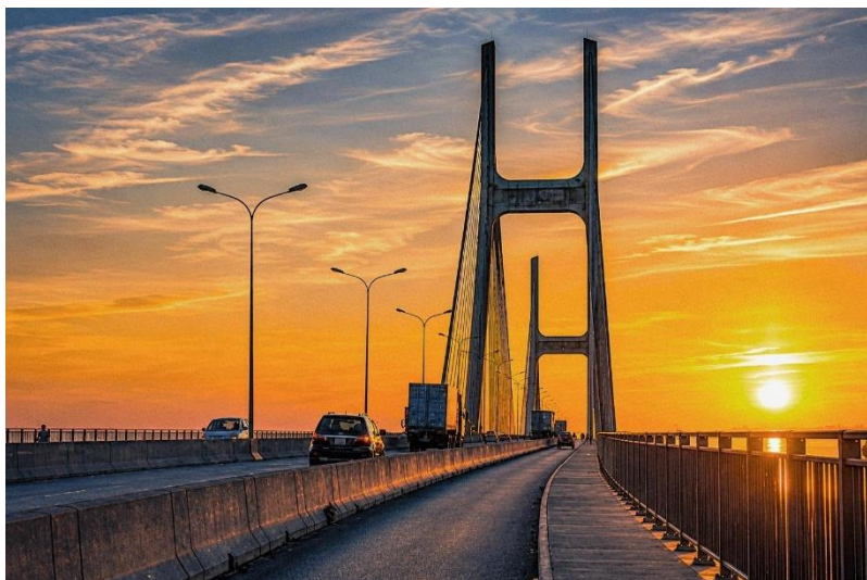
Ảnh: Cầu Phú Mỹ Quận 7
